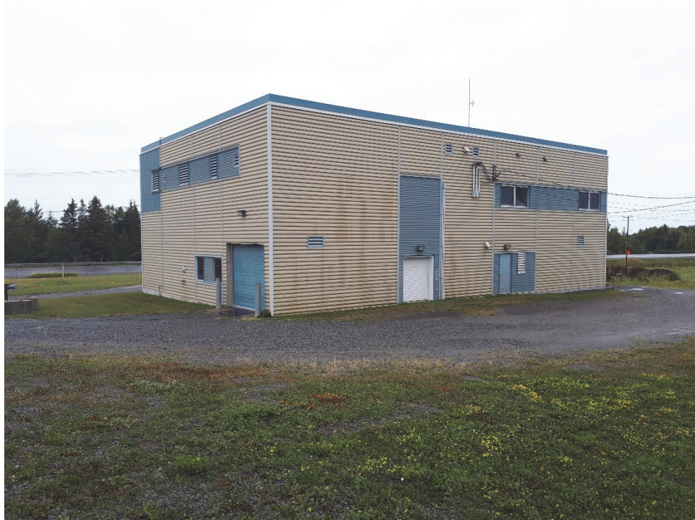
Photo 2 : Aperçu du bâtiment de production d'eau potable (usine de filtration) – 2019-08-29
