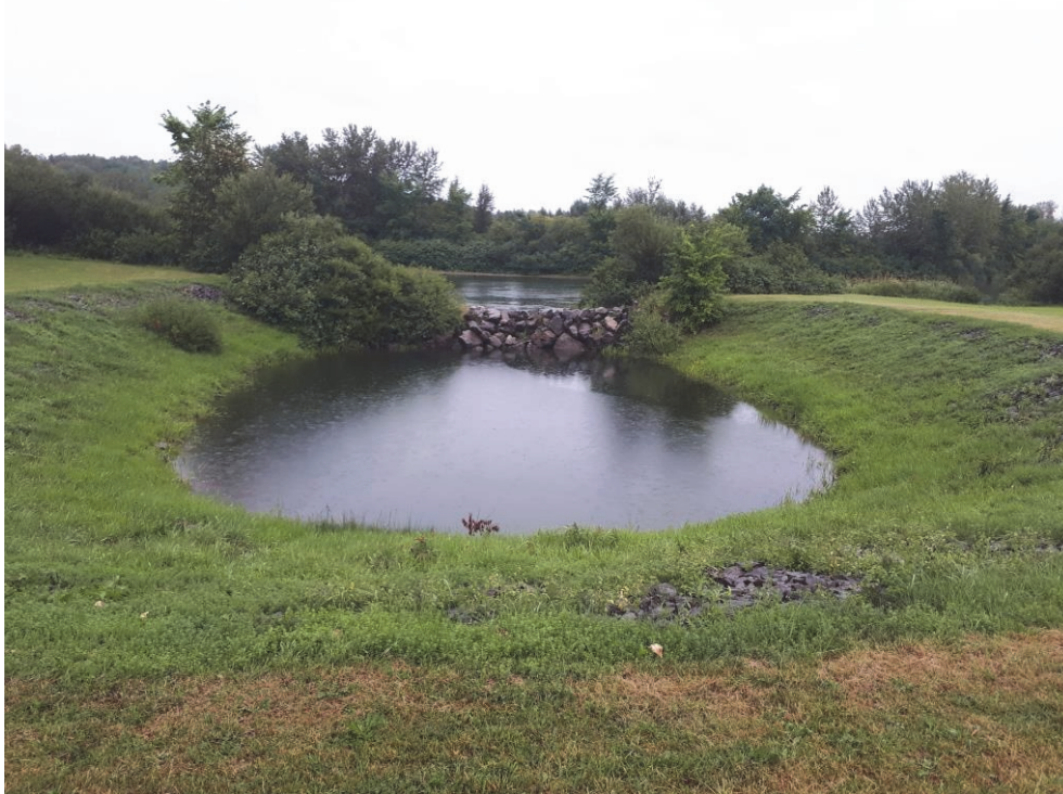
Photo 1 : Aperçu du bassin de captage, où l'eau est prélevée – 2019-08-29
